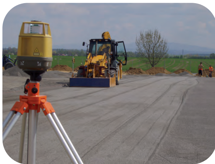
System leveller na koparko-ładowarce. Na pierwszym planie niwelator laserowy.
